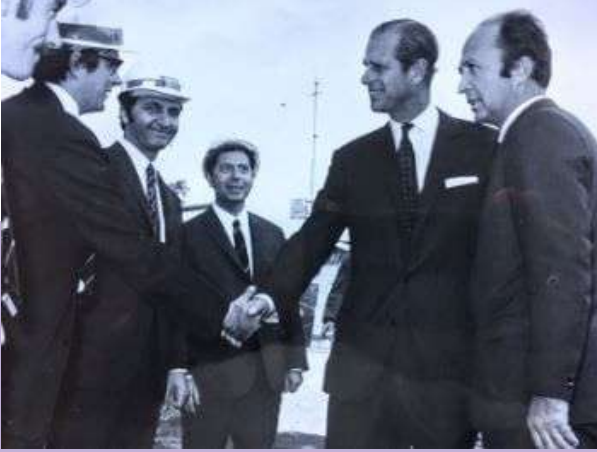
Prens Philip Boğaziçi Köprüsü inşaatında
